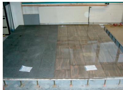
Fertige Versuchsflächen nach der Verfugung mit Ultracolor Plus
