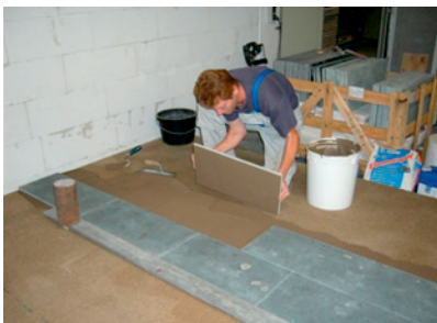
Verklebung der Platten im Buttering-Floating-Verfahren mit Elastorapid
