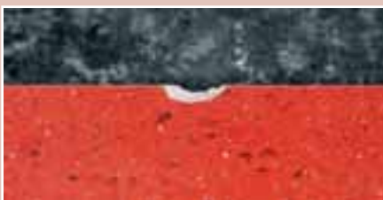
Beispiel einer Schadensbehebung mit farblich eingestellten Granulaten
