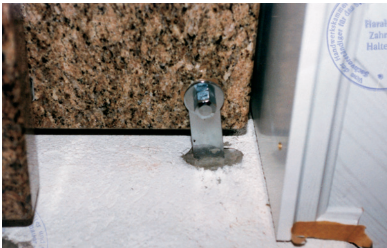
Schräg eingebauter Wandanker
