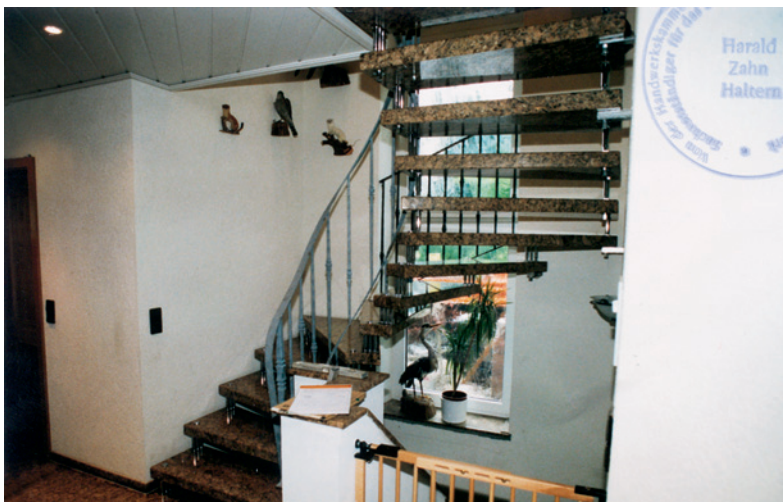
Die freitragende Treppe
