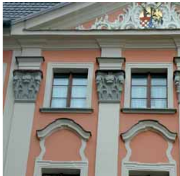
Heimatmuseum in Memmingen: Die Weber Naturstein GmbH und die Firma Ludwig Schütz renovierten korinthische Säulenkapitelle und Sohlbänke aus RORSCHACHER SANDSTEIN
