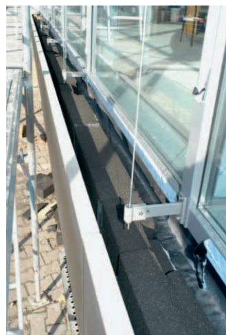
FOAMGLAS® leistet konstanten Wärmeschutz auch am Gebäude-Fußpunkt mit Sandsteinplatten: selbst im stark feuchtebelasteten Fußpunkt von Gebäuden wird mit Schaumglas konstanter Wärmeschutz geboten.
