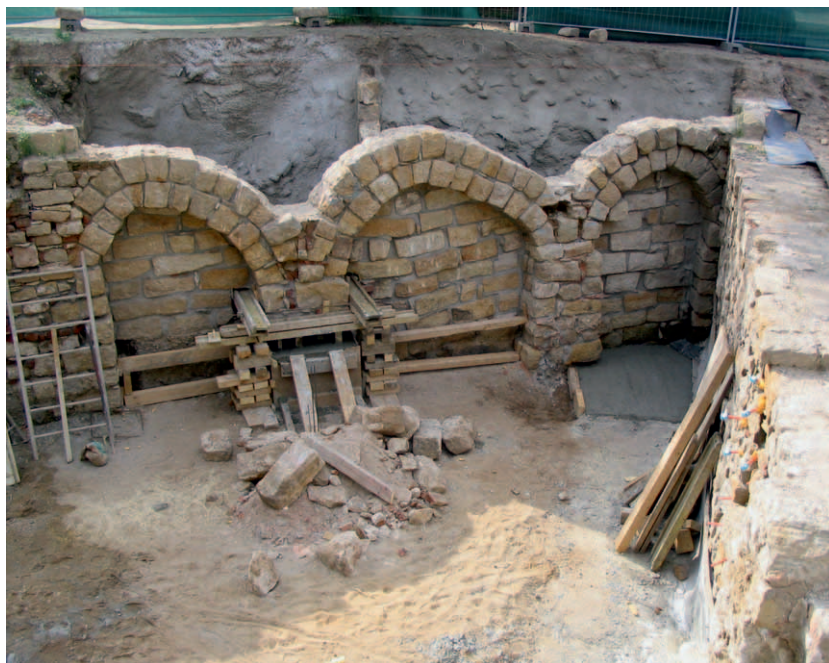
Für die Ertüchtigung belasteter Bauteile kam der Verpressmörtel HSTV-P zum Einsatz.
