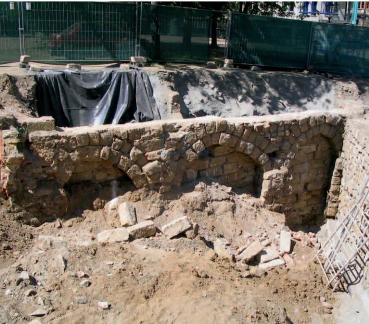
Die alten Sandstein-Kellergewölbe waren stark beschädigt.
