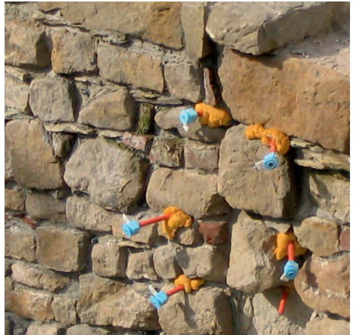
Fugensanierung mit hochsulfatbeständigem Trass-Zement-Mörtel
