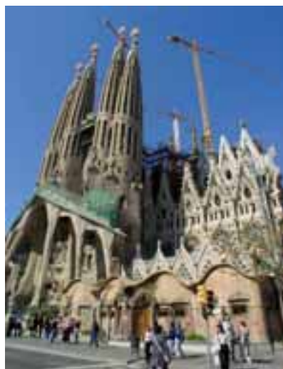
An der noch unvollendeten »Sagrada Familia« von Antonio Gaudí in Barcelona kam u. a. Granit von Piedranova zum Einsatz.
