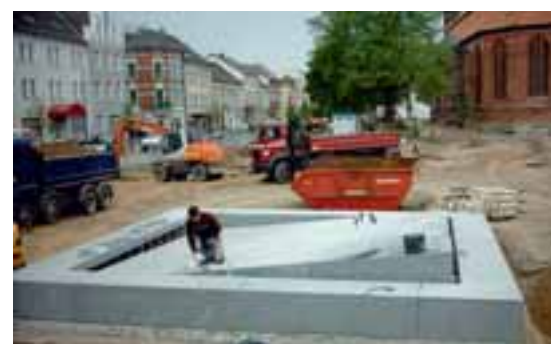
Montage der Brunnenanlage im Stadtzentrum
