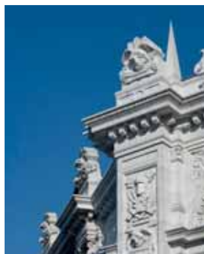
Banco de España in Madrid von Rafael Moneo; Carrara Marmor, Kalkstein aus Alconera, Granit aus Alpedrete und BATEIG Sandstein
