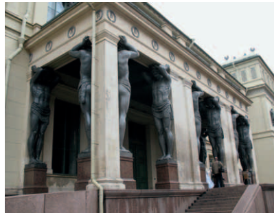
Atlanten am Portikus der Neuen Ermitage aus dem dunklen Tiefengestein SERDOBOL vom Ladogasee-Gebiet
