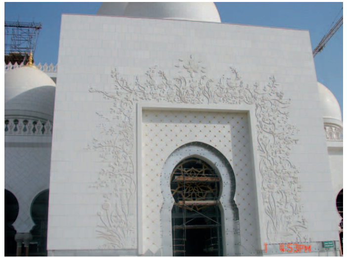
Torgebäude mit Fassadenreliefs aus SIVEC
