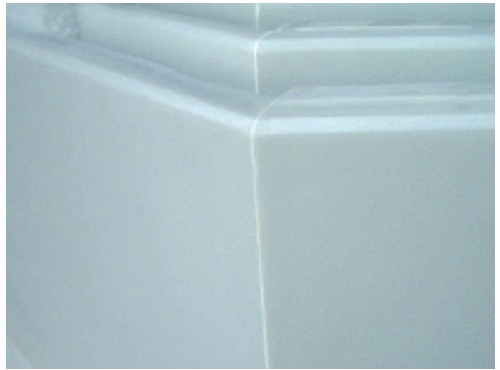
Verklebung mit AKEPOX 5010
