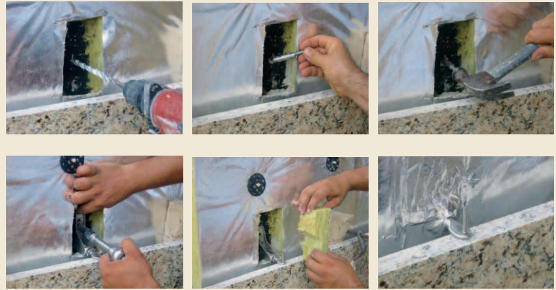
Befestigung von Fassadenplatten mittels Body-Ankern zum Andübeln
