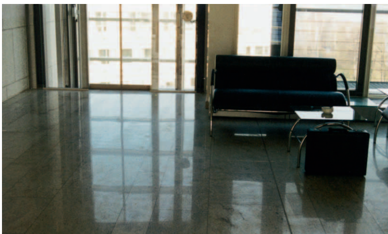
Fleckenbildung und Schlieren im Gegenlicht
