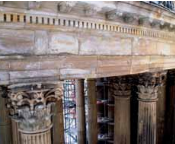
Säule und Architrav (rötlich): WÜNSCHELBURGER, darüber (hell) RACKWITZER, buntes Einsprengsel im Architrav: UMMENDORFER, Balustrade: COTTAER
