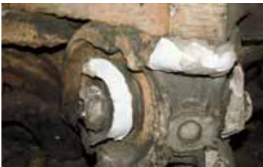
Demontiertes Kapitel aus UMMENDORFER. Die Kruste steht noch. Dahinter sandet der Stein stark ab.
