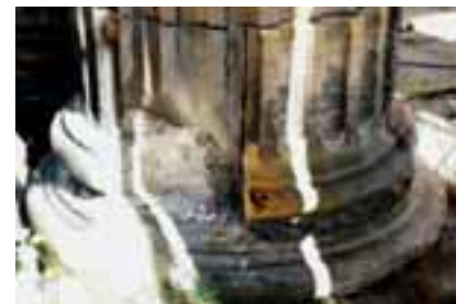
Absandungen und Aushöhlungen an Säulenbasen (UMMENDORFER)
