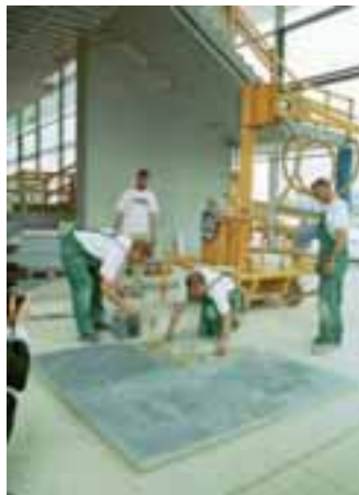
Neue Messe Stuttgart: Verlegung mit Sopro-Produkten
