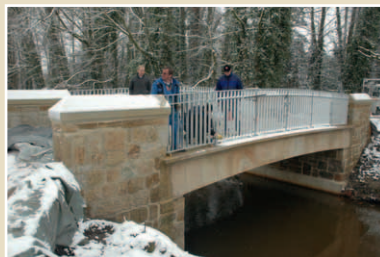
Geländermontage auf dem fertigen Brückenbauwerk
