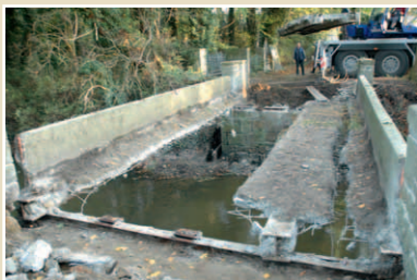
Demontage der alten, korrodierten Stahlträger samt Betonguss
