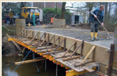
Gießen der Brücke in die Schalung aus Sandsteinplatten und Unterschaltung
