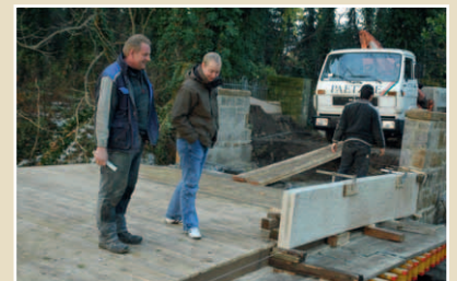
Bogensteine beim Aufbau, gleichzeitig Randschalung für den Betonguss
