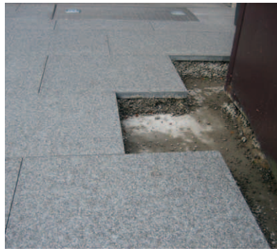
Sanierung mit Monokornaufbau
