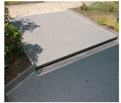
Nach der Sanierung ist keine Verfleckung mehr erkennbar
