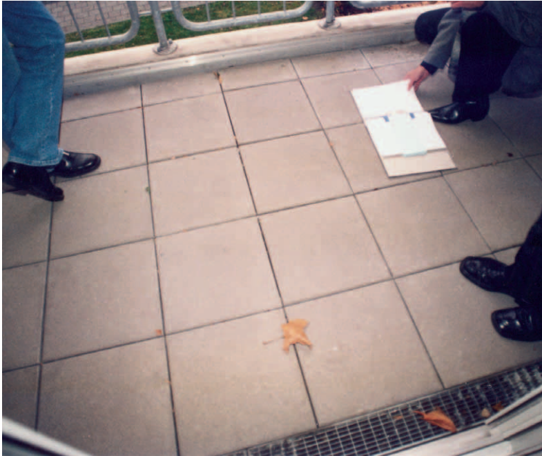
Ortstermin auf den 42 Balkonen
