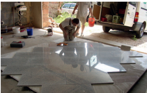
Belegung einer Versuchsfläche mit Naturwerkstein
