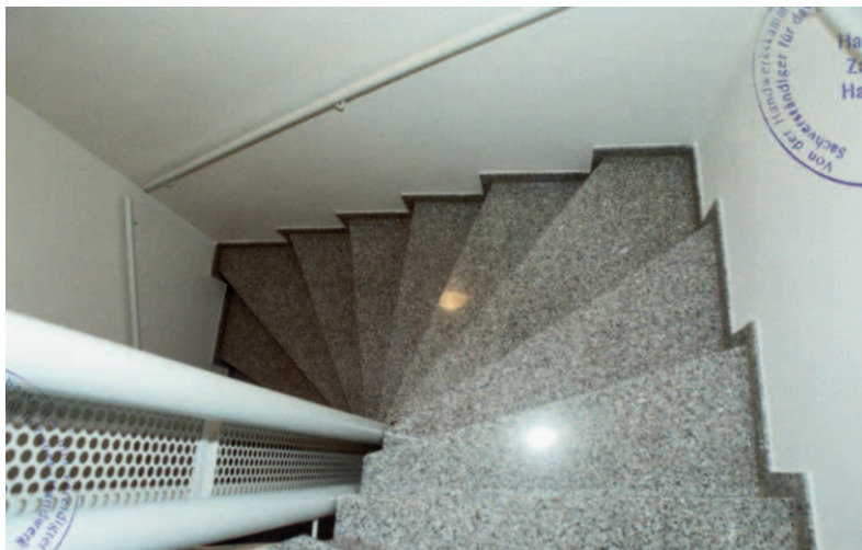
Treppe ohne Flecken in den Obergeschossen
