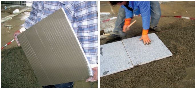
Die aufgebrachte Haftbrücke und das Einklopfen der Platte in das frisch aufgezogene Mörtelbett.
