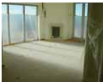
Vorher: fein geschliffene und gereinigte Bodenfläche
