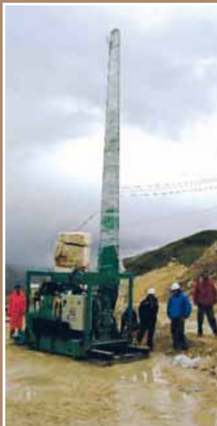
Das Schwert der neu installierten Schrämmaschine von Garrone misst 7,40 m.
