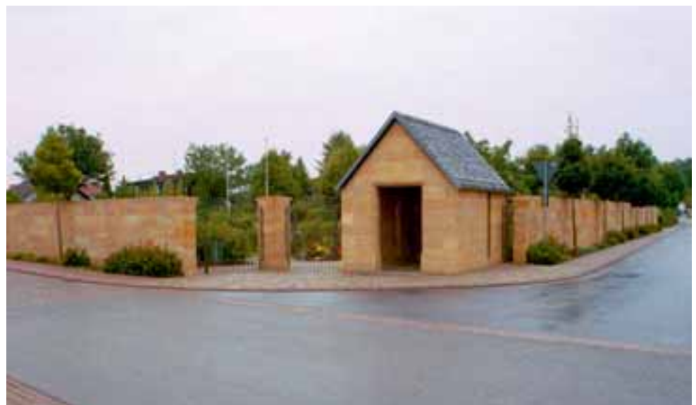
Für die Kemmaer Friedhofsmauer samt Kapelle verarbeitete Naturstein Brehm 110 m 3 BUCHER SANDSTEIN, 2002
