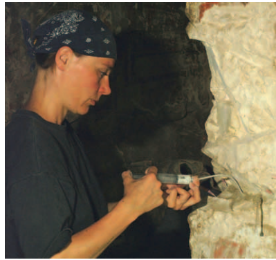
Riss- und Hohlraumverfüllung des geschädigten Kalksteingefüges mit mineralischem Injektionsmörtel
