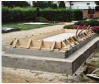
Das Fundament für die Grabanlage
