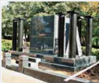
Die acht Säulen aus SCHWARZ SCHWED-Granit und der halbfertige Urnenraum
