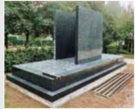
Der Urnenraum wird errichtet
