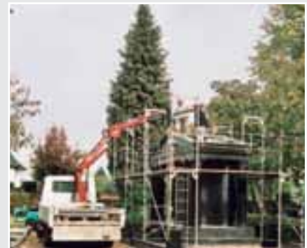
Arbeiten am eingerüsteten Mausoleum
