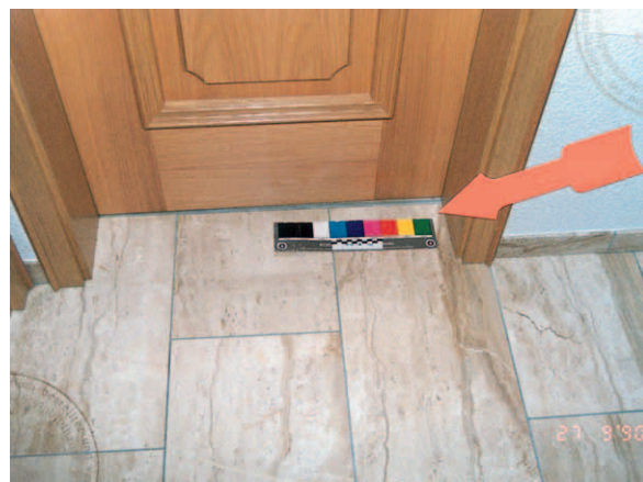
Keilfuge am Türblatt
