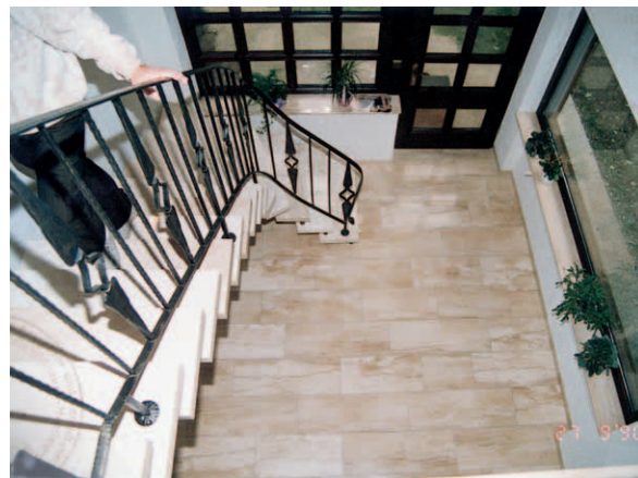
Bodenbelag und Treppe
