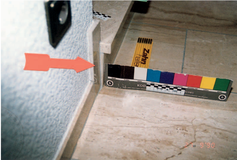
Setzstufe 4 mm außer Lot
