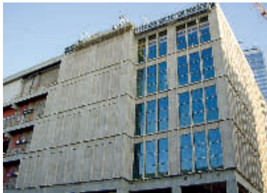
Massive Lisenen und Gesimse lockern die großen Fassadenflächen auf.
