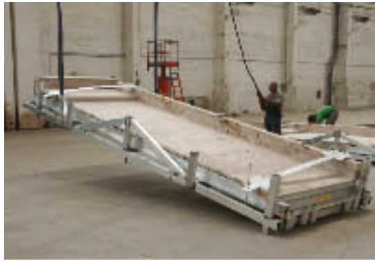
Die 1,70 x 6,80 großen Elemente wurden vorproduziert und in die Verankerungskonstruktion eingehängt.
