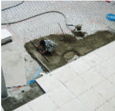
Objekt »NRW-Bank« mit Fußboden- heizung und Monokorn
