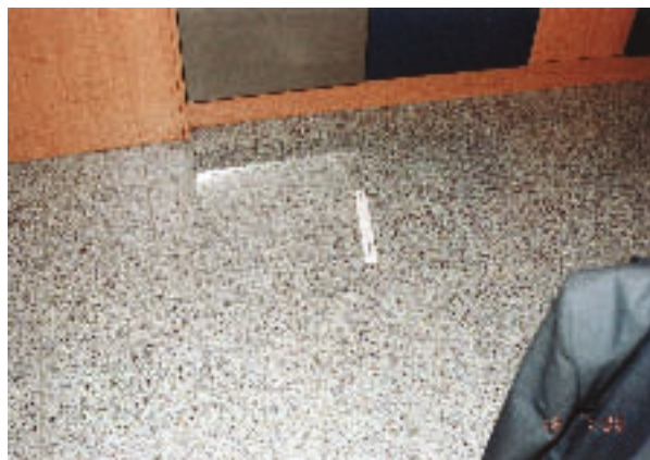
Bodenbelag mit unterschiedlicher Struktur, Gesamtansicht
