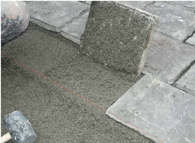
Die rückseitig aufgetragene Haftbrücke gewährleistet die Verbundhaftung zum Einkornmörtel.
