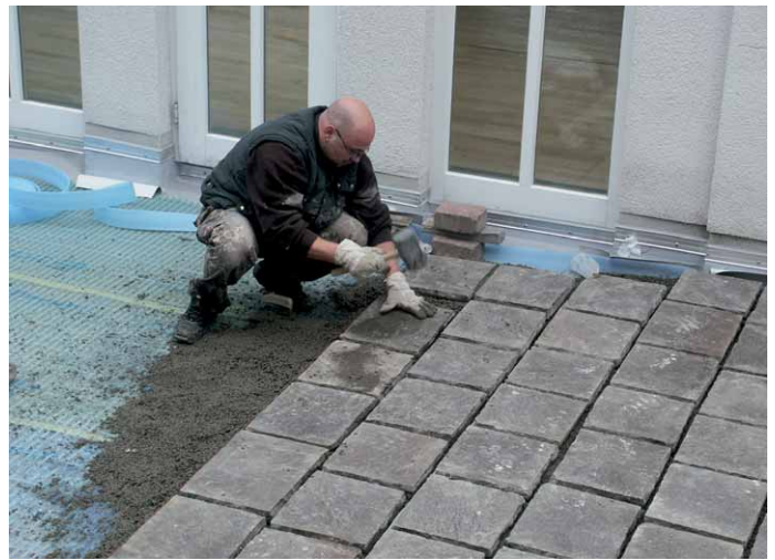
Die Drainmatte liegt in Gefällrichtung. Die ungleich dicken Platten werden in den darauf vorgezogenen Einkornmörtel eingeklopft.
