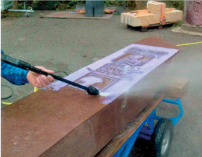
Bild 1: Nach dem Sandstrahlen wird die umweltverträgliche Folie mit Hochdruckwasserstrahl abgewaschen
