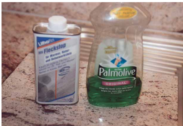
Die Flächen wurden zu spät imprägniert und falsch gereinigt.
