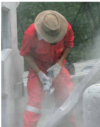
Tran Hoang Co bei der Arbeit
