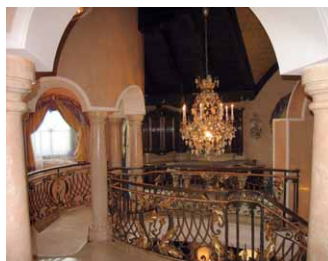
Das Eingangsfoyer im Treppenhaus mit Säulen, Bodenbelägen und Treppen aus ROSA PERLINO
