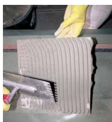
Aufgetragene Kleberschicht
