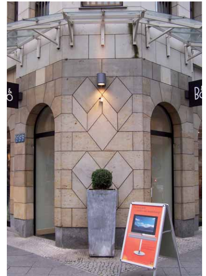
Außenfassade mit Sandsteinfurnier von Unikat Sedimente
