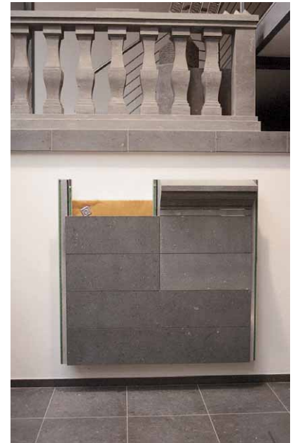
Ausstellung: Fußboden, Fassadenaufbau und Geländer mit anroechter stein
