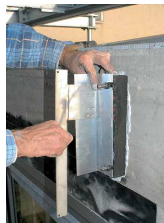
Punktueller Befestigungspunkte schwerer Fassadenbekleidung werden durch die T-Konsole auf FOAMGLAS® wärmebrückenoptimiert ausgebildet.
