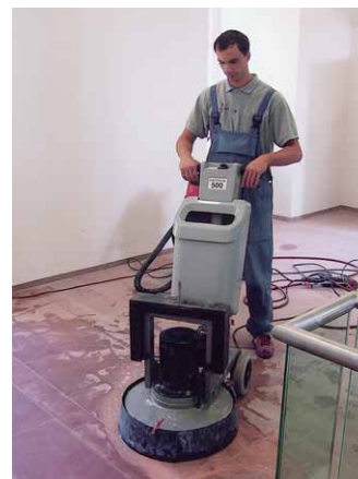
Bodenreinigung mit der Dreischeibenbodenmaschine »Hatrick«
