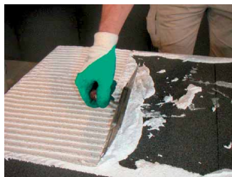
Die FOAMGLAS®-Platten werden mit dem mineralischen Kleber PC164 durch diagonales Einschleiben auf dem Untergrund verklebt.
