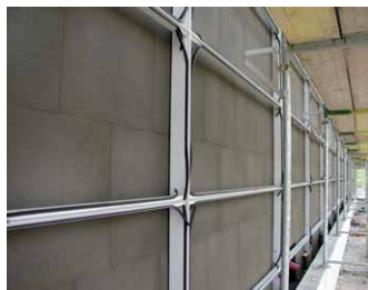
Die homogene, kompakte Verlegung von FOAMGLAS® bietet der Fassade bestmöglichen Schutz. Der Dämmstoff ist feuchteunempfindlich.
