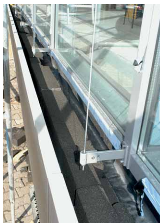
Montage von Sandsteinplatten (5cm) an einer mit FOAMGLAS® gedämmten Fassade. Selbst stark feuchtebelastete Zonen werden konstant gedämmt.
