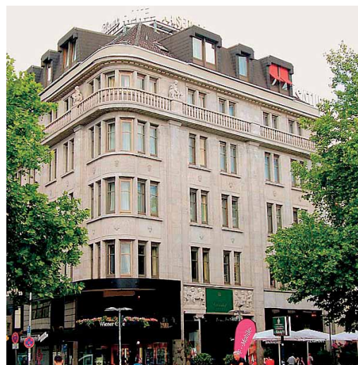
Das Hotel Kaiserhof nach der Niederdruck-Wirbelstrahlreinigung
