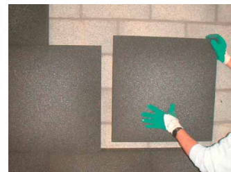
Mit FOAMGLAS® lassen sich Hinterlüftungsräume auf das konstruktiv notwendige Maß reduzieren. Das spart Kosten und bringt zusätzlichen Wohnraum.
