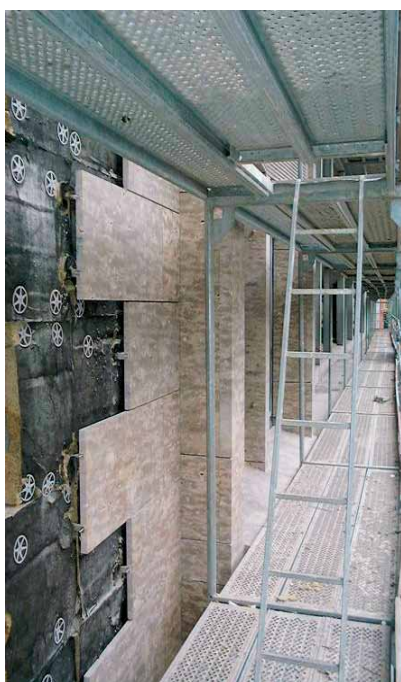
Abb. 1: Fassadenverankerung
