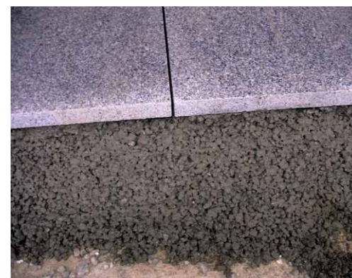
3 cm dicker Granit mit 15 cm dickem Monokornmörtel
