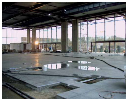
Mit Monokornmörtel verlegt: Bodenbelag auf der Messe Düsseldorf
