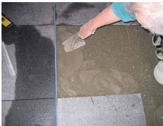
Verlegung auf frischem, estrichgerechten Monokornestrich
