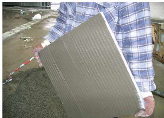
Mit Monokornmörtel verlegt: Bodenbelag auf der Messe Düsseldorf
