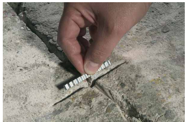
Einlegen des Wellenverbinders
