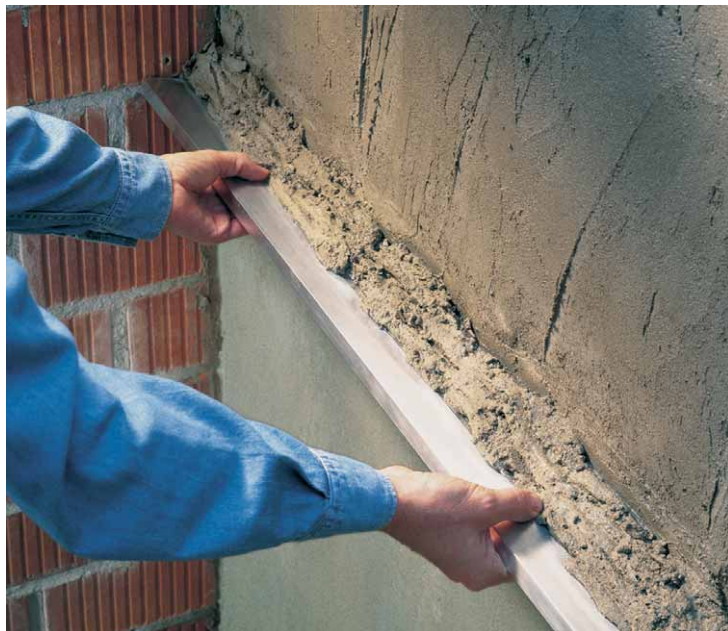
Aufziehen von ARDEX AM 100 an der Wand
