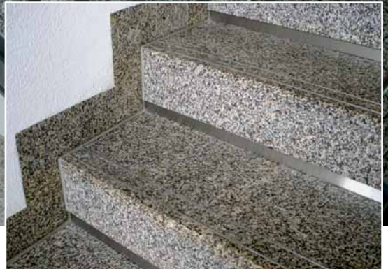
FLOSSENBÜRGER GRANIT prägt das neue Rathaus in Schwandorf.
