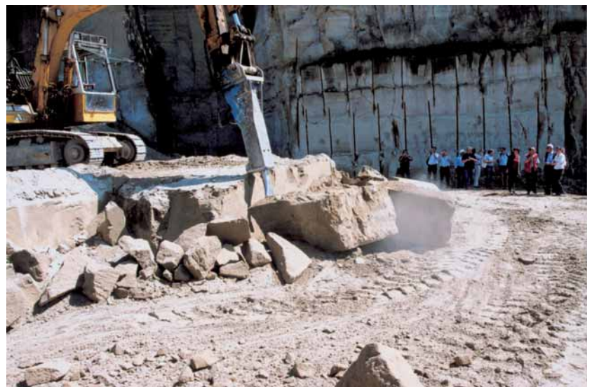
Dann können die Blöcke mit einem Meißelbagger herausgebrochen werden.
