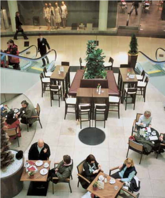
Bodenbelag aus geschliffenem Granit im Format 60 x 60 cm
