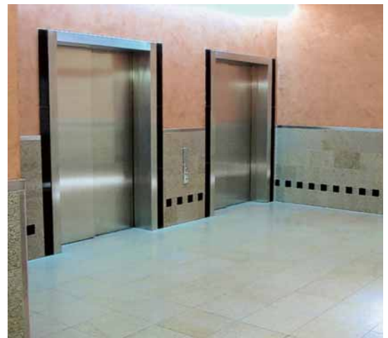
Aufzugsbereich: Granit und Basalt schützen bis Augenhöhe die Zwischenräume der Aufzüge vor Verschmutzungen. Der Naturstein am Boden ist geschliffen, der an der Wand ist poliert.
