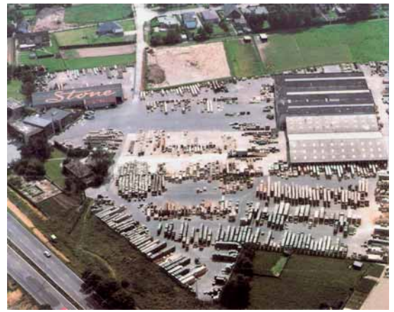
Luftaufnahme des Firmengeländes von Stone mit dem 40 000 m 2 großen Lager in Londerzeel / Belgien
