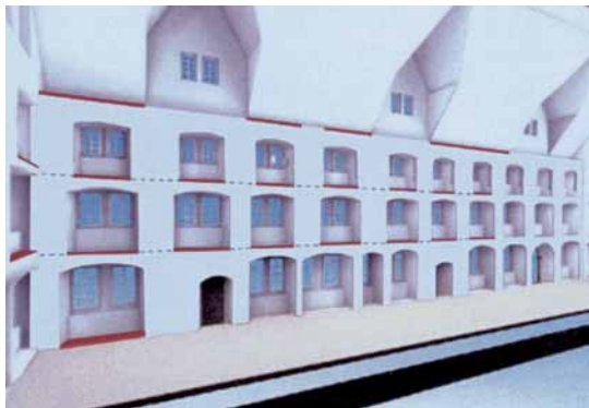
An diesen Stellen wurden die Mauern des Hochzeitshauses in Hameln bewehrt.
