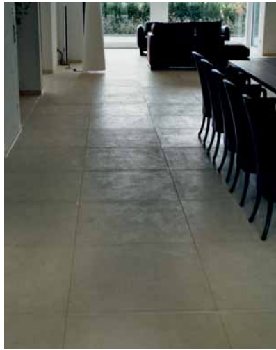
Von dieser »Master-Line« aus wurde geplant und verlegt.
