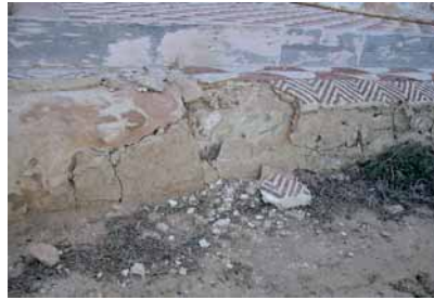
Schäden durch den Eintrag von Salz und Feuchtigkeit: Pflanzenbewuchs, Verwölbungen und Absprengungen
