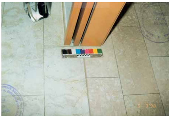
Übergang alter und neuer Boden
